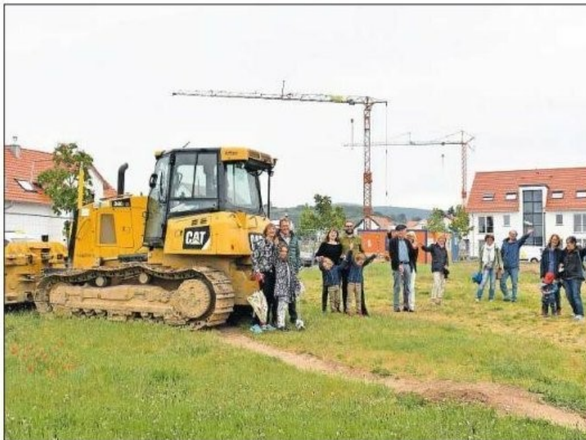
Jetzt geht's los: Die Arbeiten am Wohnprojekt im Fronhof II haben begonnen.
